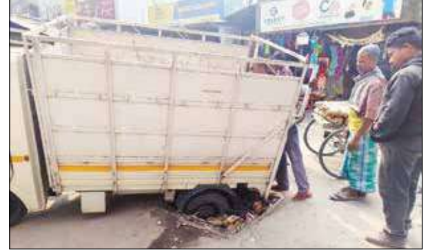
ইসলামপুর পুরসভার চেয়ারম্যানের ওয়ার্ডে রাস্তার কালভার্টের স্ল্যাব না থাকায় দুর্ঘটনাগ্রস্ত গাড়ি। বৃহত্তর।
