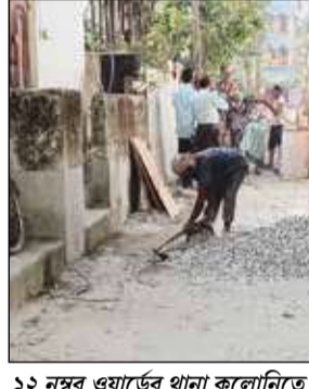
১২ নম্বর ওয়ার্ডের থানা কলোনীতে রাস্তার মাঝে নির্মাণ সামগ্রী-ফাইল চিরা।
