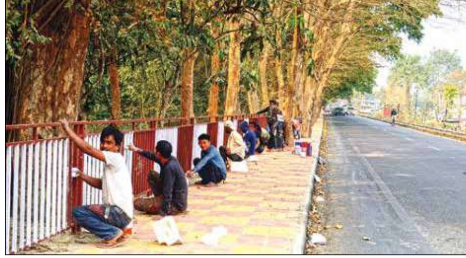
মোহরগাঁও-গুলমা চা বাগানের মেইন রোডে খোশমেজাজে রাস্তার কাজে মহিলা শ্রমিকরা। (ডানে) সুকনা রোডে পুরুষ রংমিষ্টিরা। বুধবার সূত্রধরের তোলা ছবি।
