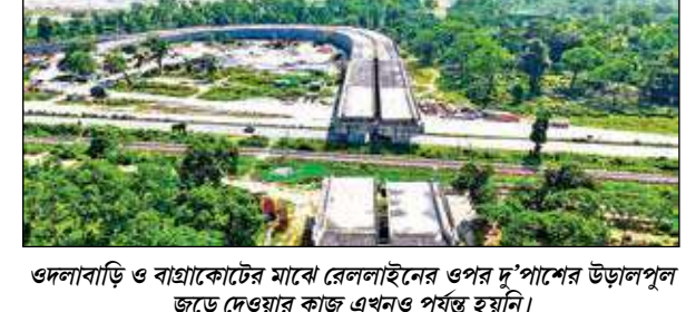
ওদলাবাড়ি ও বাথাকোটের মাঝে রেললাইনের ওপর দু'পাশের উড়ালপুল জুড়ে দেওয়ার কাজ এখনও পর্যন্ত হয়নি।
