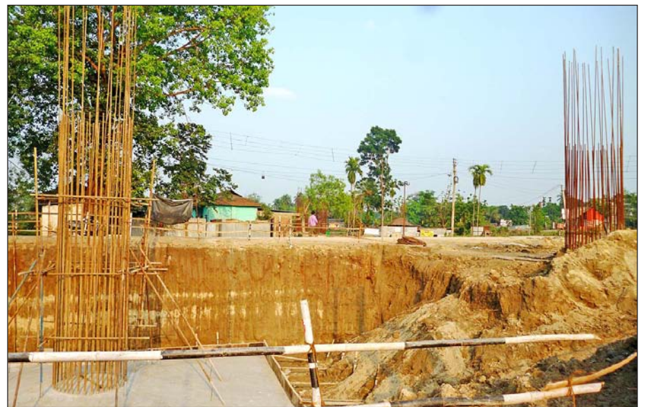
জলপাইগুড়ির মোহিতনগরে উডালপুল তৈরির কাজ থমকে রয়েছে।—সংবাদচিত্র
